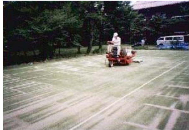
サンドスプレッダによる調整硅砂の充填
