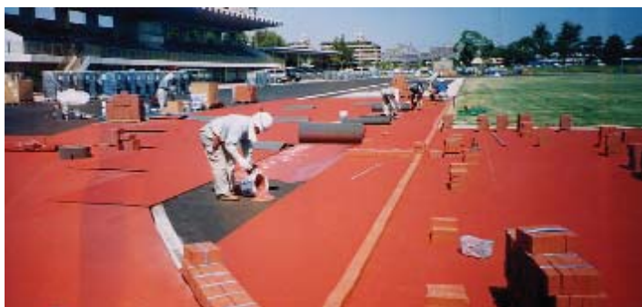
合成ゴム敷物タイプ施工風景
