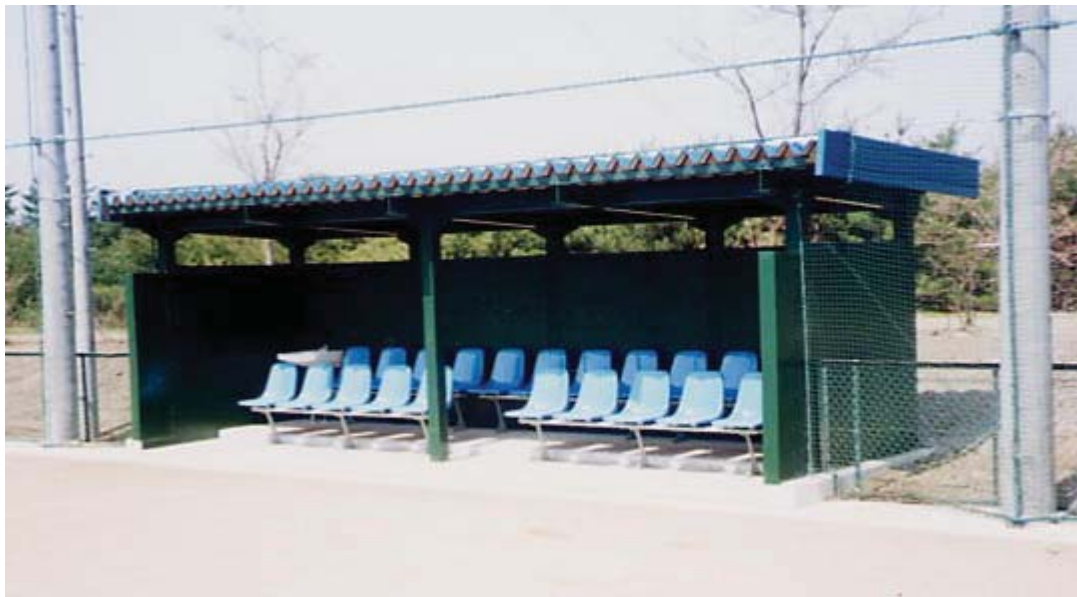
ダッグアウト（コンクリートブロック造）
