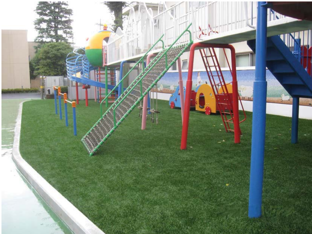
遊具周りのロングパイル人工芝敷設
