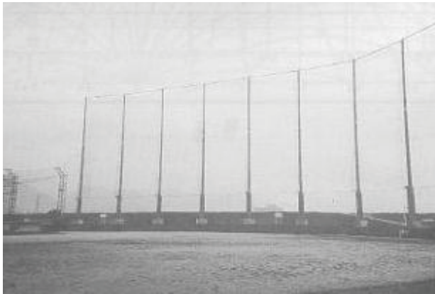
写真-2 防球ネット上昇状態
