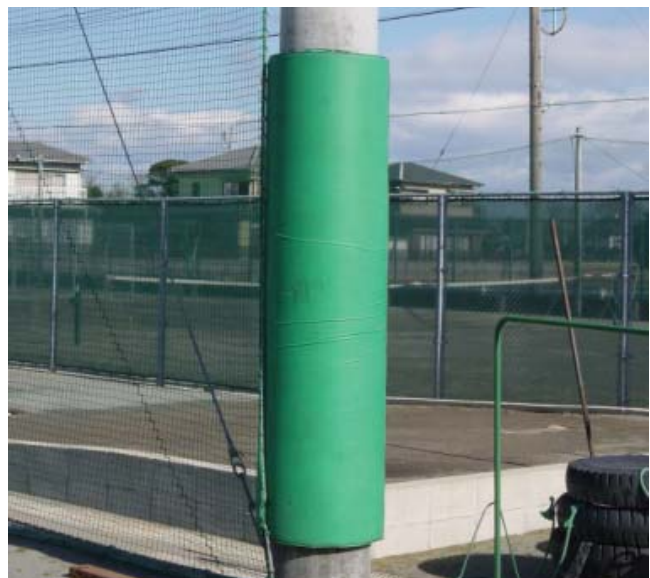
支柱の安全対策
