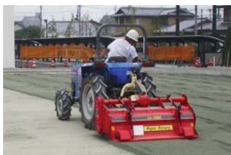
トラクタによる掘起し作業
